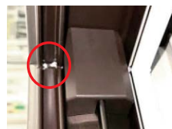
例：引違い窓 下枠 コーナー部 溶着塊
